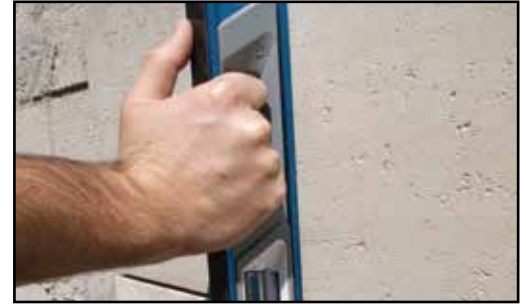
Use un nivel grande para verificar y mantener un plano de cara uniforme sobre distintas losetas.
