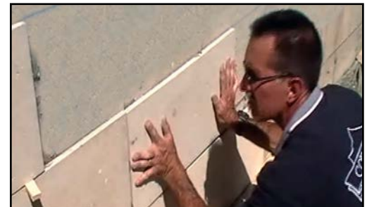
Coloque la piedra contra la pared con un movimiento de izquierda a derecha hasta que la mezcla de mortero se exprima desde el perímetro de la loseta y se logre una adhesión de cobertura total.
