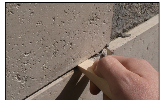
Se deben usar espaciadores para mantener uniformes las uniones.
