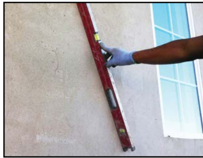
Use un borde largo o recto para confirmar que la pared es plana.
