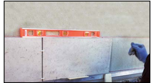
El uso de un canal rígido de aluminio puede ayudarlo a soportar y nivelar la primera fila de losetas durante la colocación.
