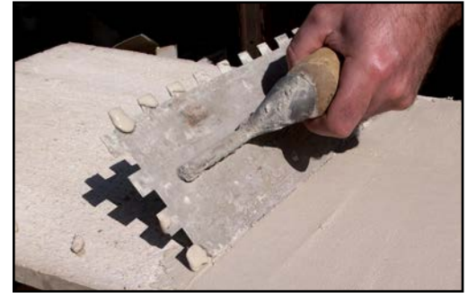
Aplique una capa de adelgazante modificado con polímero en la parte posterior de la piedra.
