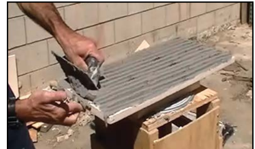
Use una llana dentada de 1/2 in (1,27 cm) para aplicar la adelgazante modificado con polímero que no se deforma en la parte posterior de la piedra.
